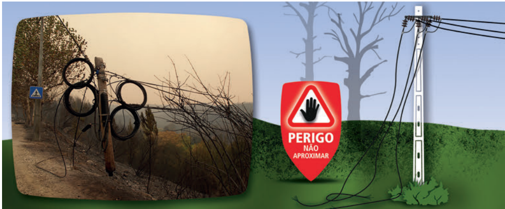
Fig. 70 Não se aproxime de cabos caídos no solo.
